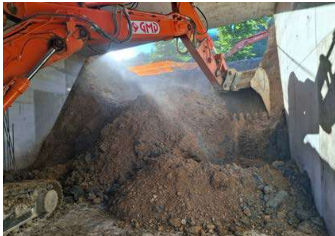
Figura 7 – Scavo dall'interno
