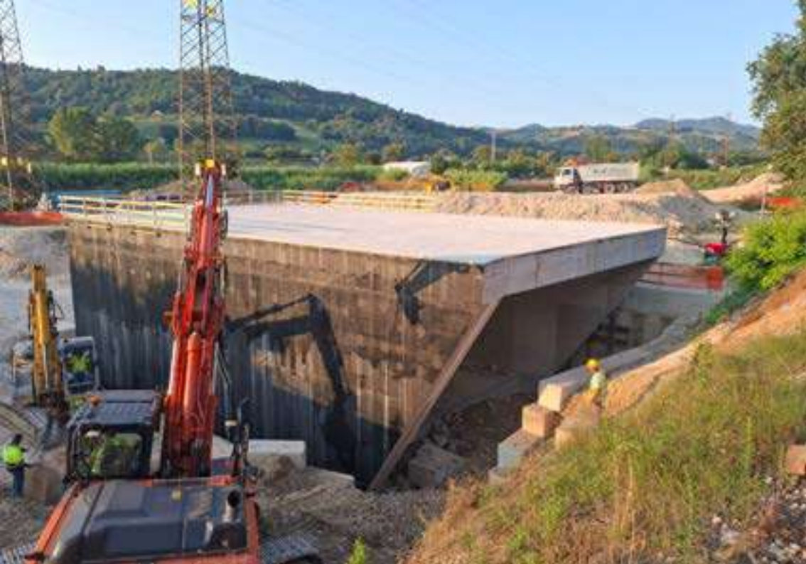
Figura 3 – Monolite prima della spinta
