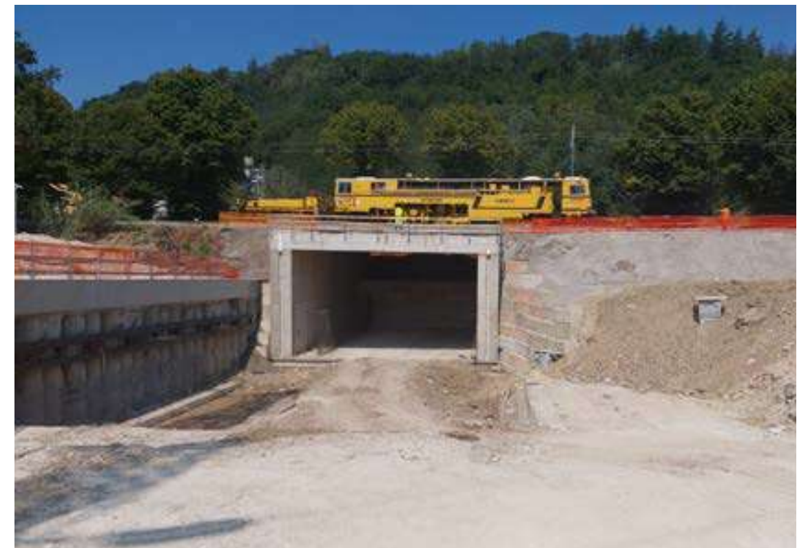
Figura 8 – Monolite in posizione finale
