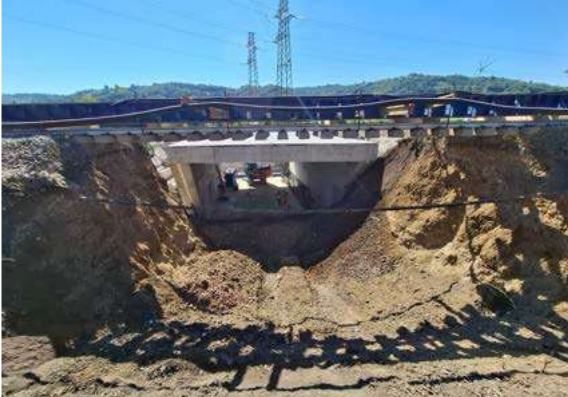
Figura 4 – Binari irrigiditi e monolite prima della spinta
