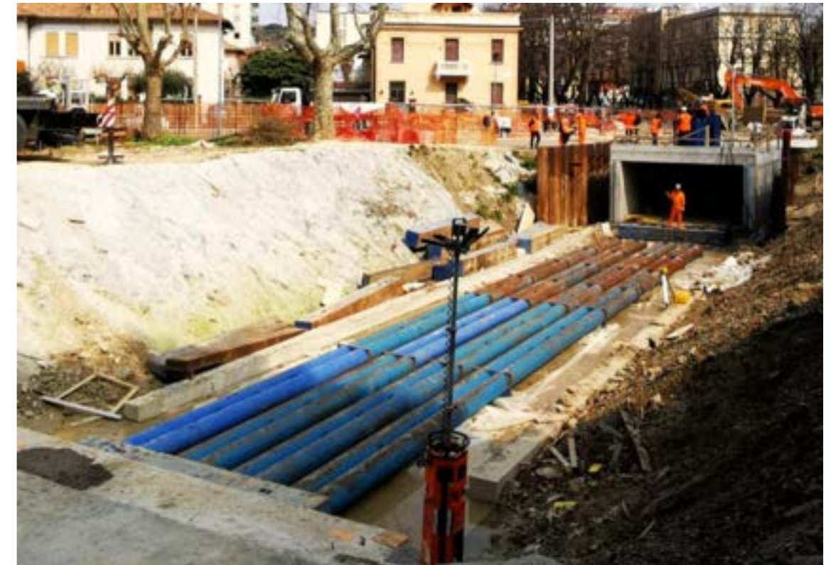
Imagen 3 - Aproximación monolito y excavación desde el interior
