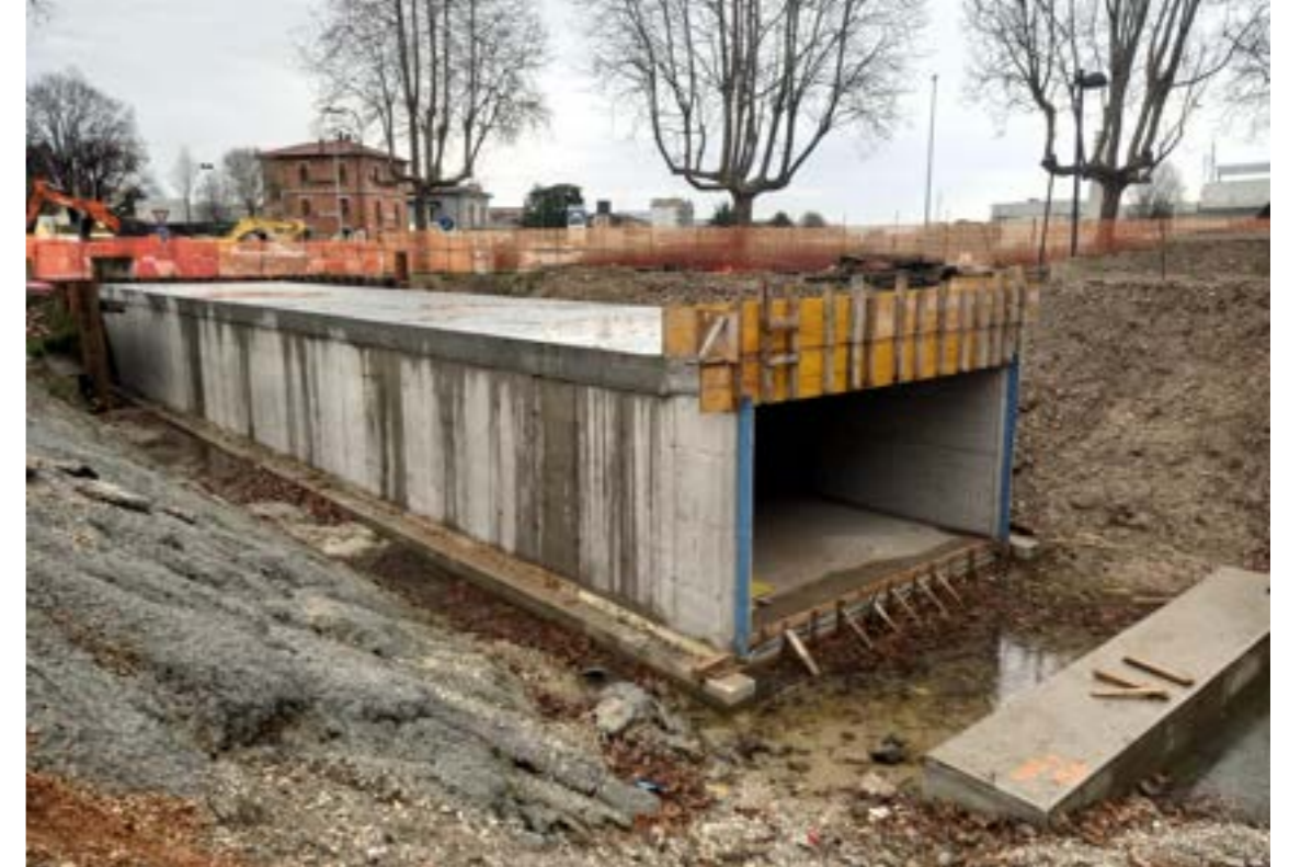
Imagen 5 - Columna de empuje y contra-solera
