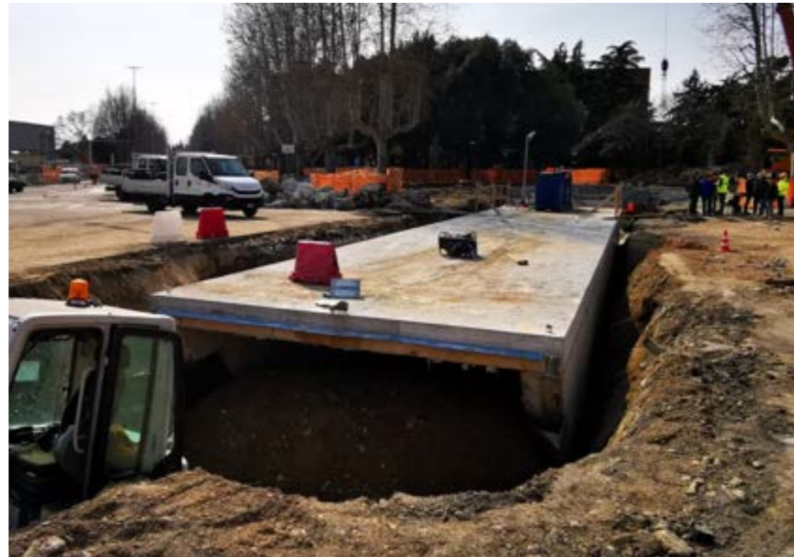
Imagen 6 - Vista de la cuña de penetración frontal
