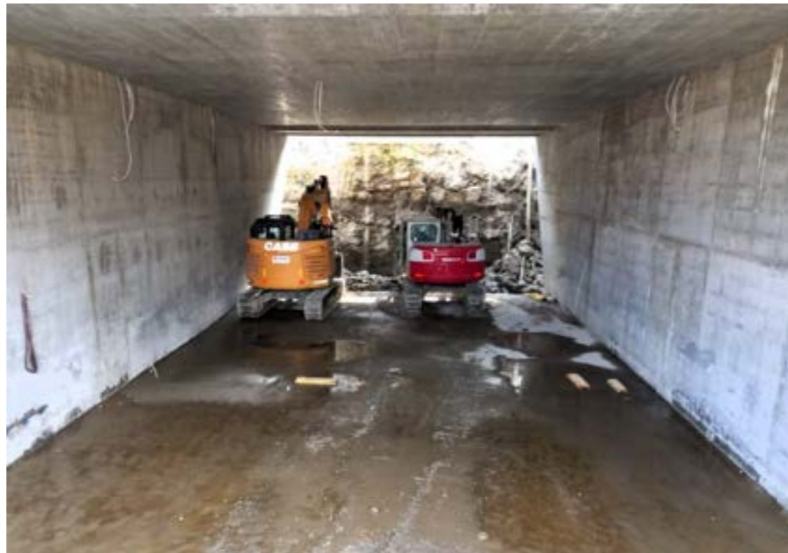
Imagen 7 - Excavación desde el interior
