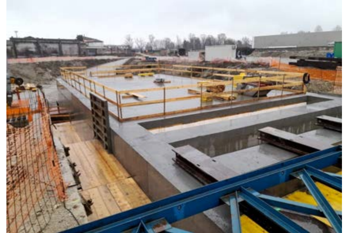
Imagen 6 - Hinca de cajón
