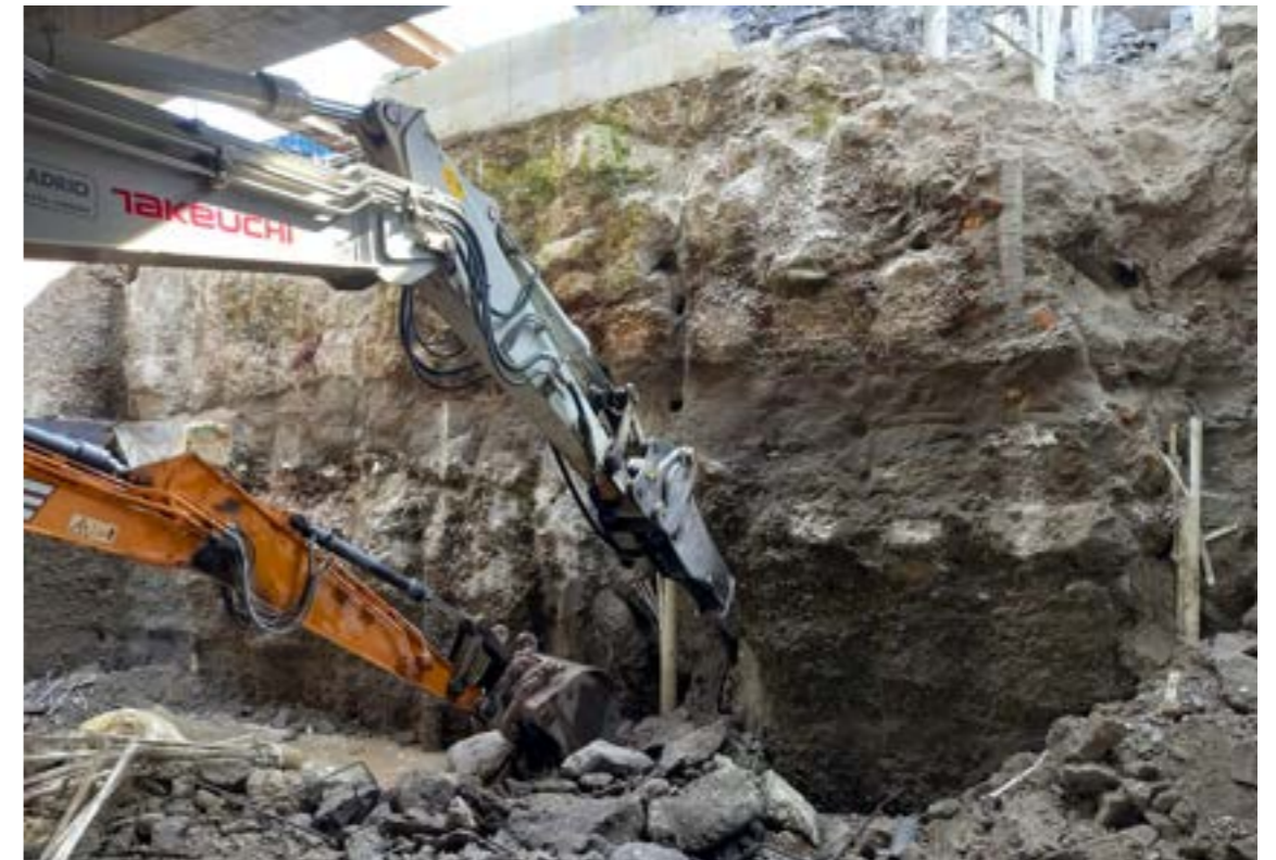
Imagen 8 - Excavación desde el interior
