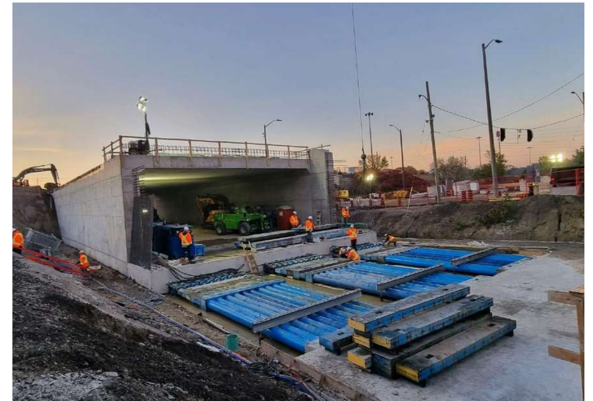
Figura 4 - Spinta monolite con martinetti e spessori
