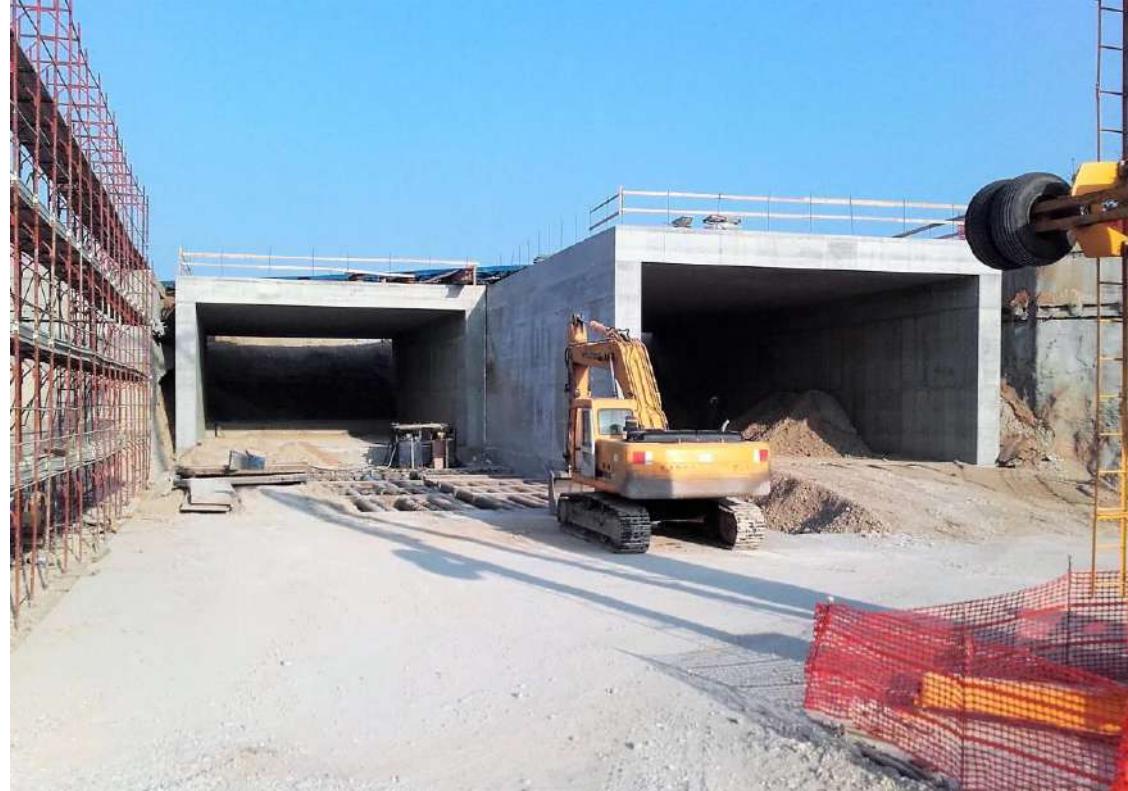
Imagen 4 – Empuje de monolitos
