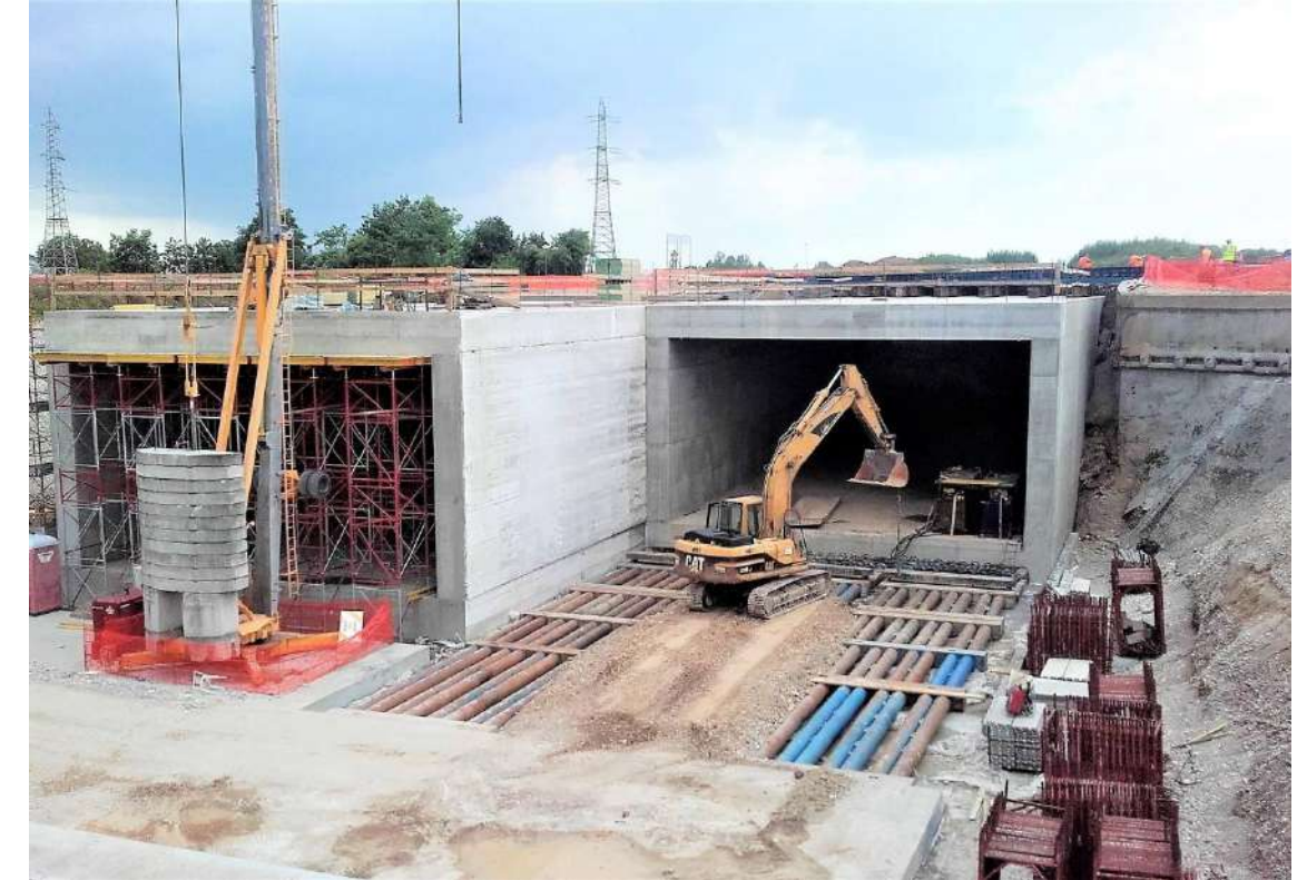
Imagen 6 – Empuje de monolitos
