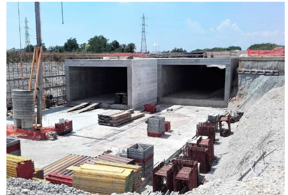
Imagen 8 – Empuje de monolitos – fases finales
