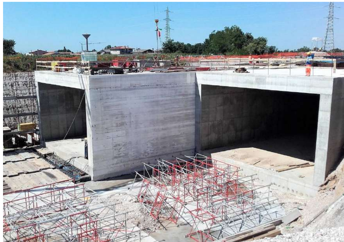
Imagen 7 – Empuje de monolitos
