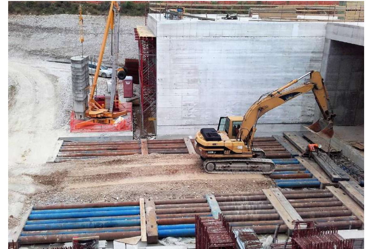
Imagen 3 – Empuje de monolitos
