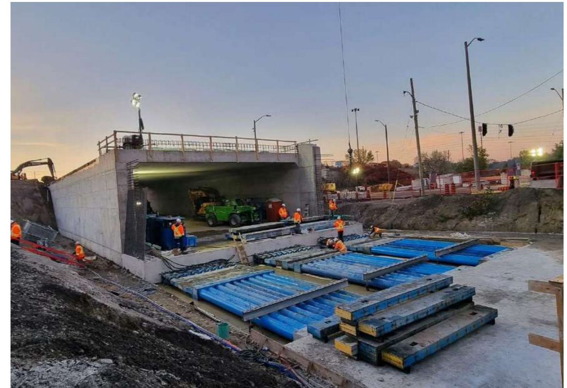
Figura 4 - Spinta monolite con martinetti e spessori
