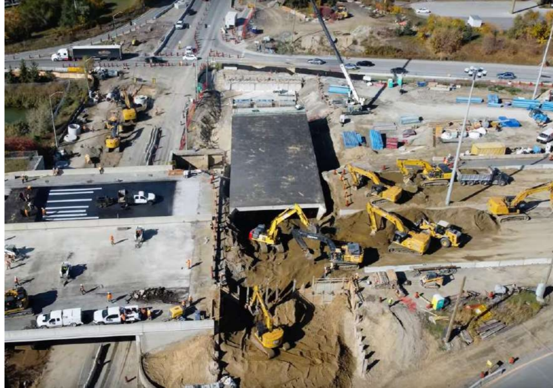
Figura 5 - Scavo a cielo aperto e monolite in avanzamento
