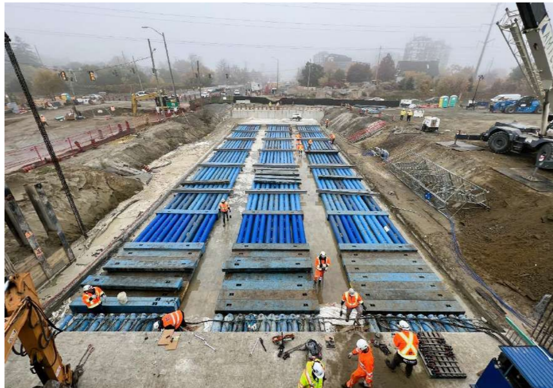
Figura 7 - Colonne di spinta a fine lavori
