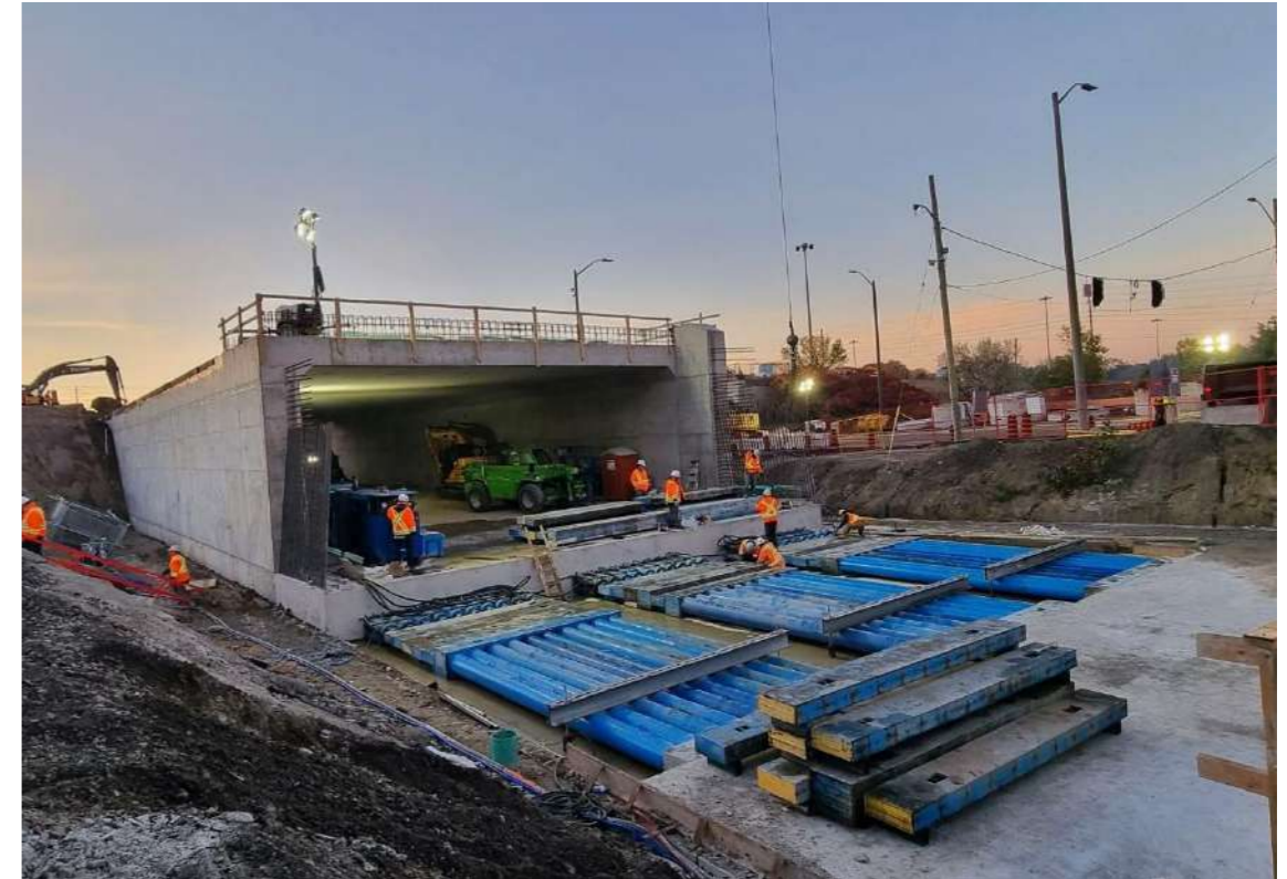
Imagen 4 - Hinca de cajón con vigas metálicas y gatos hidráulicos
