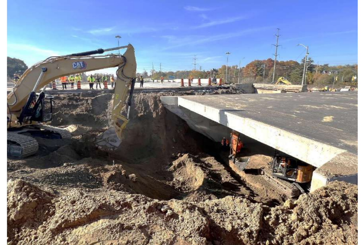
Imagen 6 – Excavación desde el exterior
