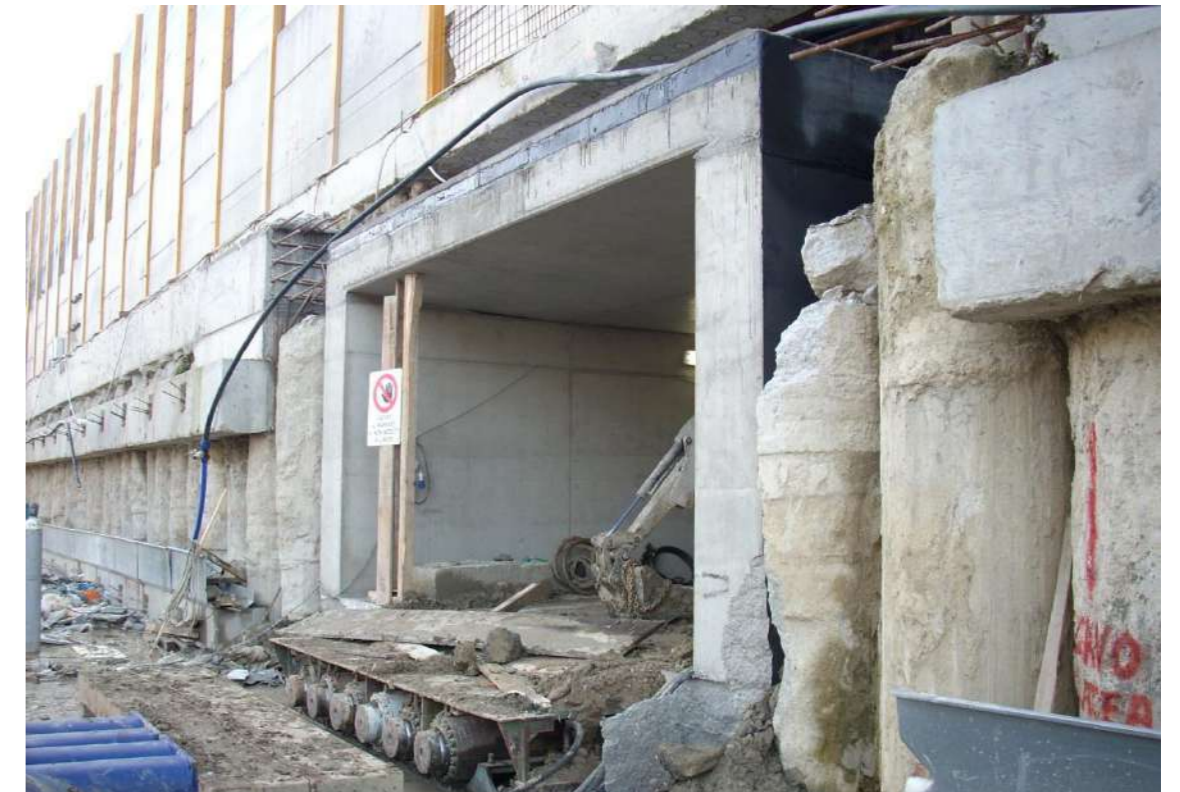
Imagen 7 - Proceso de hincas completado
