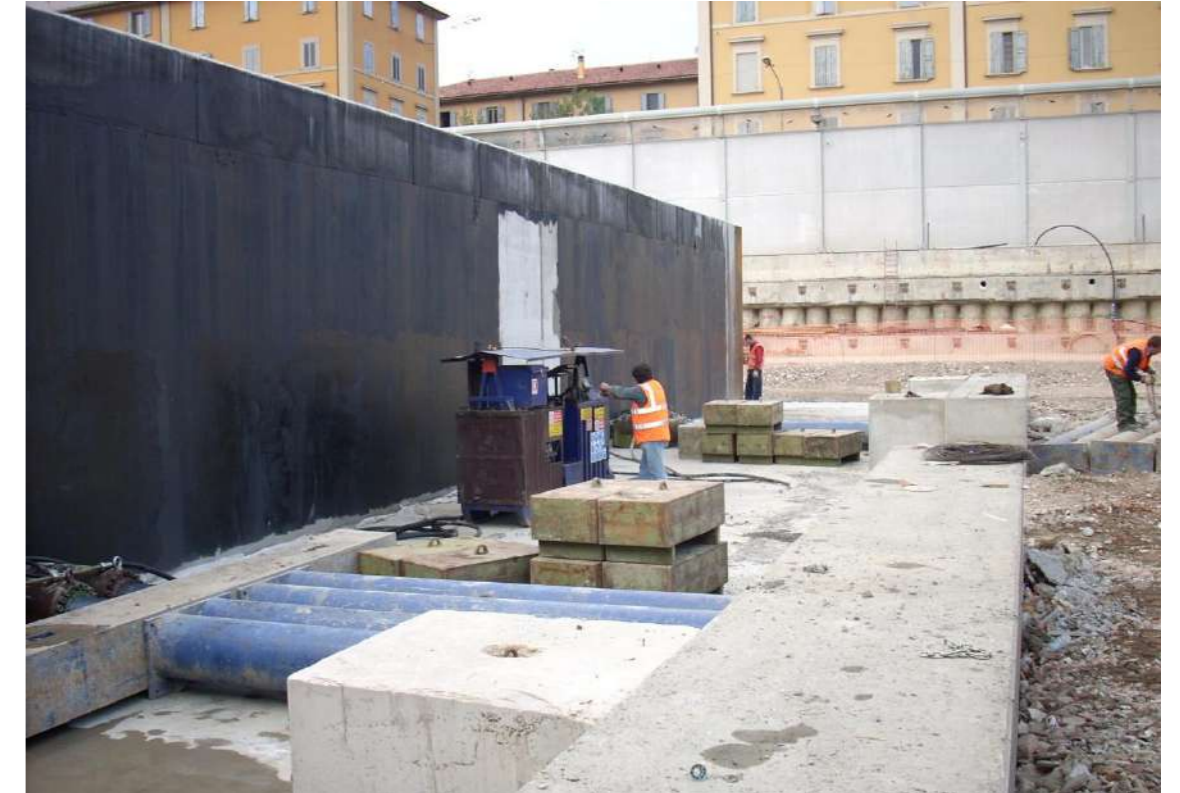
Imagen 5 - Hincas lateral del último Monolito
