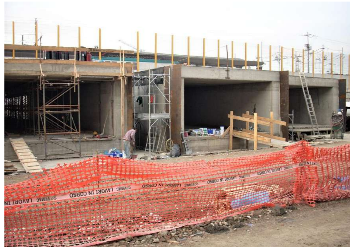
Imagen 2 - Monolitos en fase de construcción
