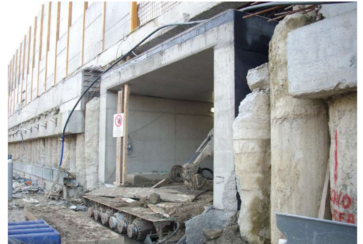
Figura 7 - Completamento del processo di spinta
