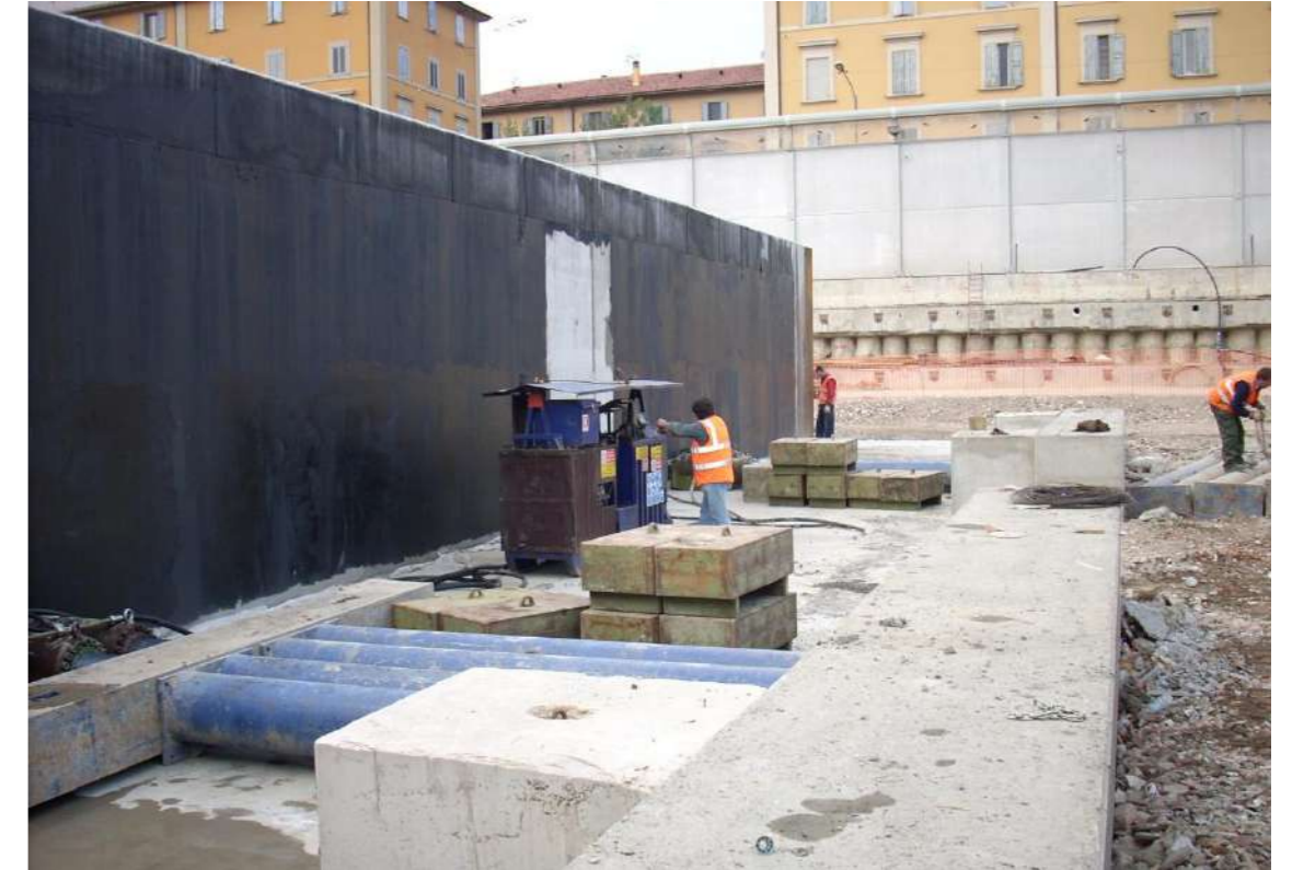
Figura 5 - Spinta laterale dell'ultimo segmento
