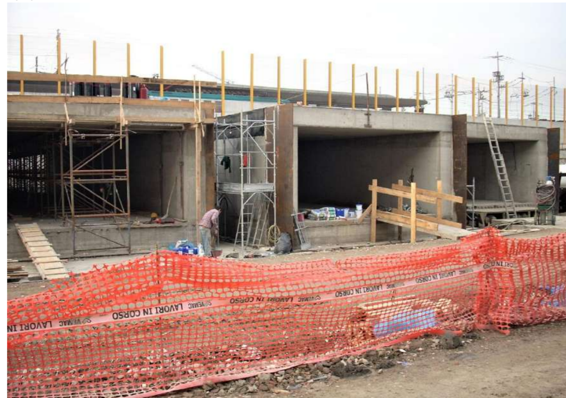
Figura 2 - Monoliti in costruzione
