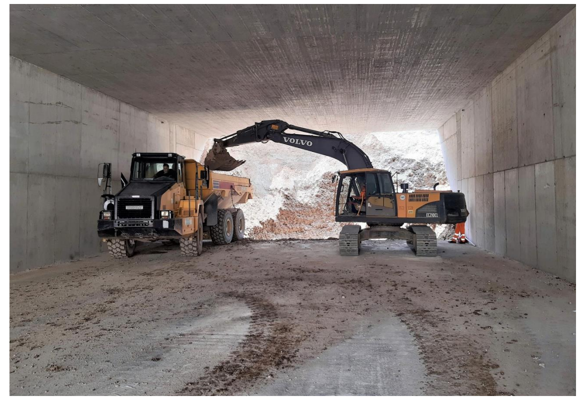
Figura 9 - Scavo dall'interno
