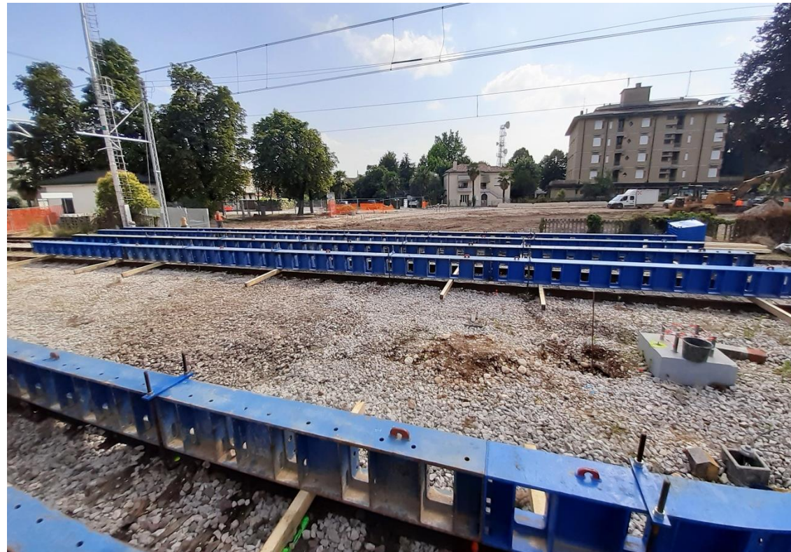
Figura 5 - Sistema verona su binari ferroviari
