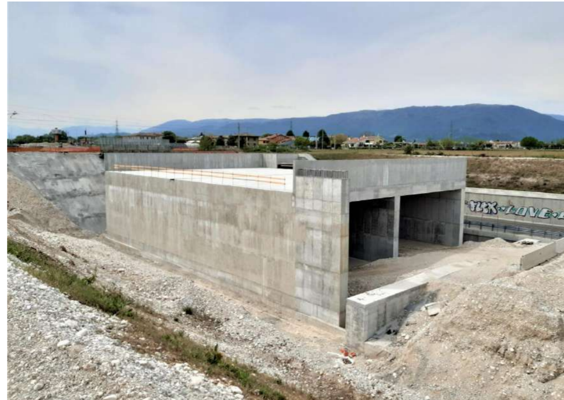
Imagen 3 - Vista del monolito antes de la hinca
