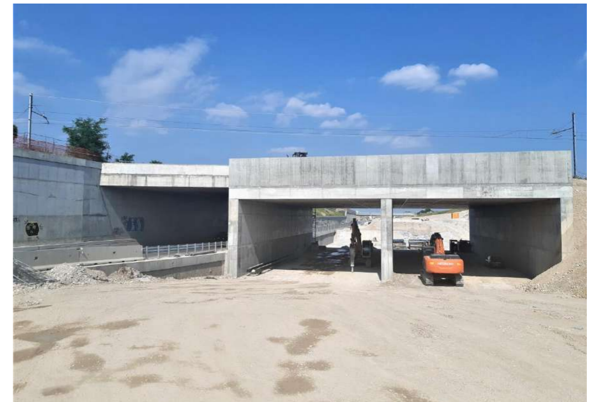
Figura 9 - Vista del monolite in posizione finale
