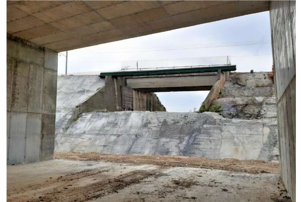
Figura 7 - Vista dall'interno dello scatolare
