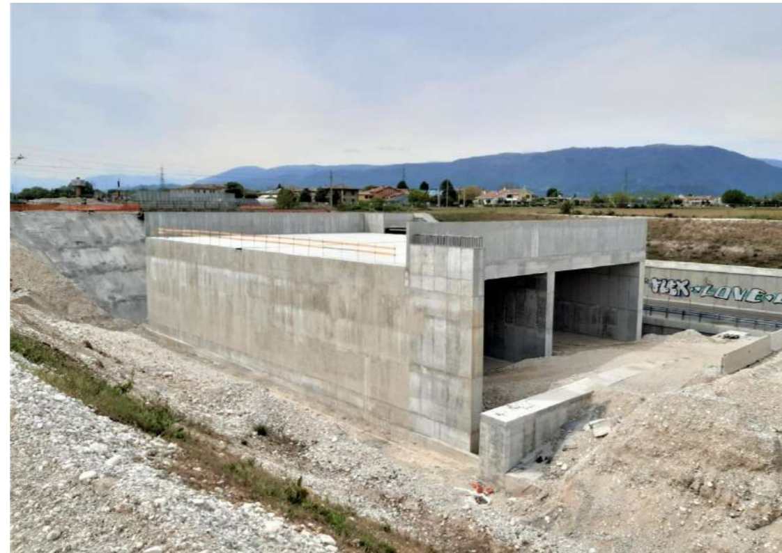
Figura 3 - Vista del monolite prima della spinta
