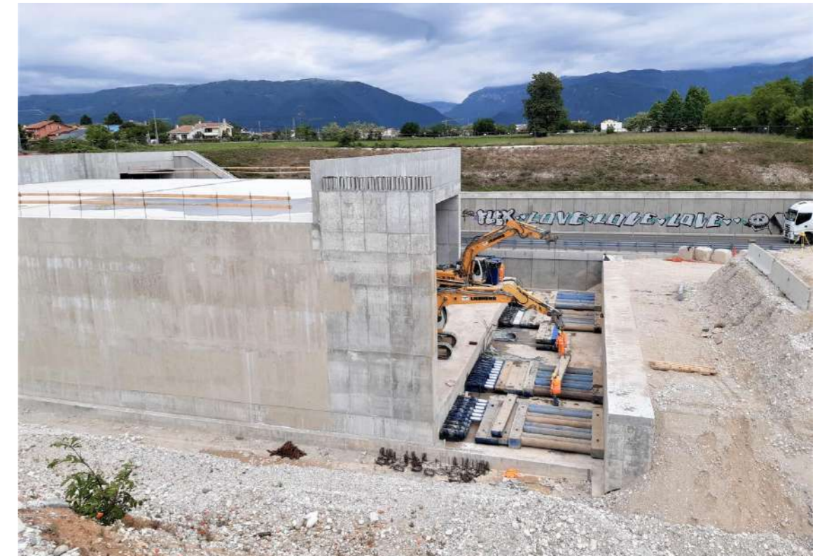
Figura 4 - Monolite durante la spinta
