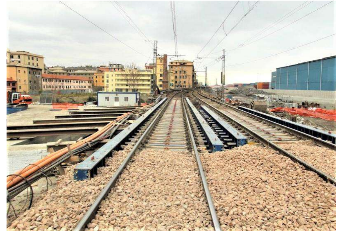
Imagen 5 - Vigas de maniobra y el Sistema Verona
