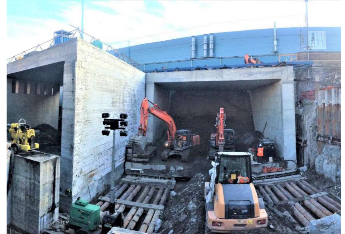
Imagen 7 - Vista de los dos monolitos durante la hincada
