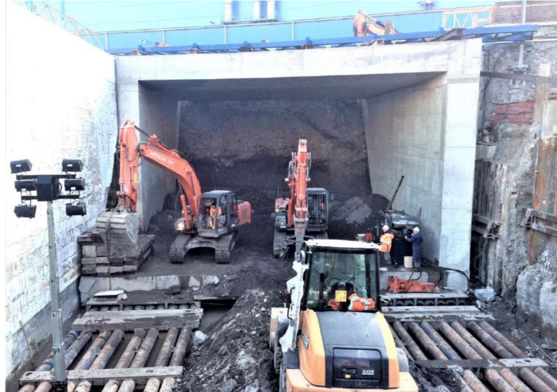
Imagen 6 - Hincada de paso inferior con gatos hidráulicos
