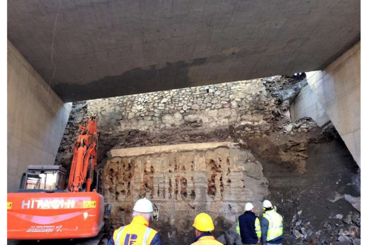
Imagen 9 - Excavación desde el interior
