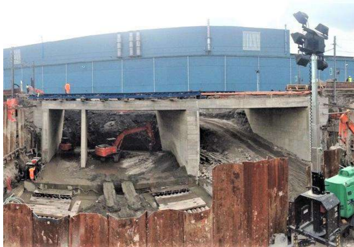
Imagen 8 - Fases finales de la hincada
