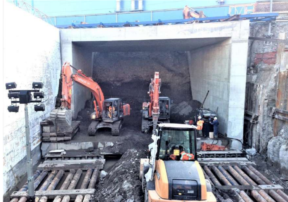
Figura 6 - Spinta dello scatolare con martinetti idraulici
