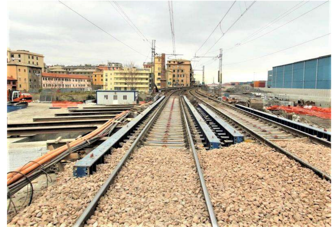
Figura 5 - Travi di manovra e Sistema Verona
