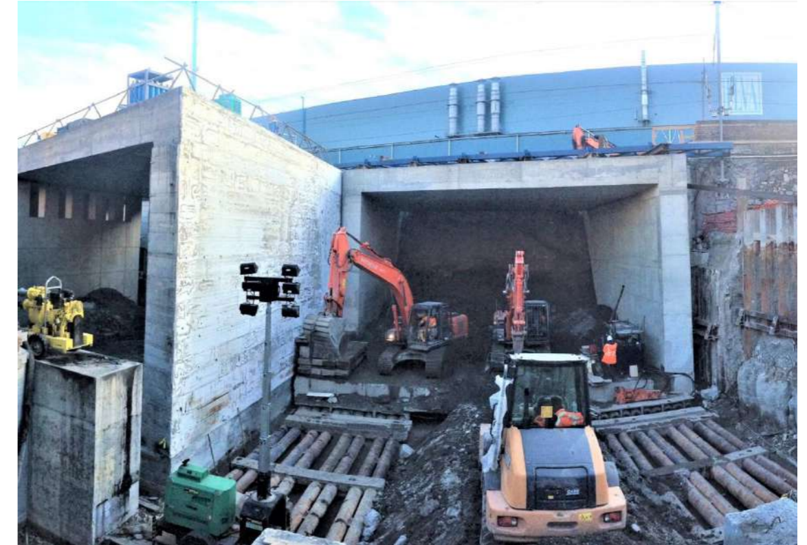
Figura 7 - Vista dei due monoliti durante la spinta
