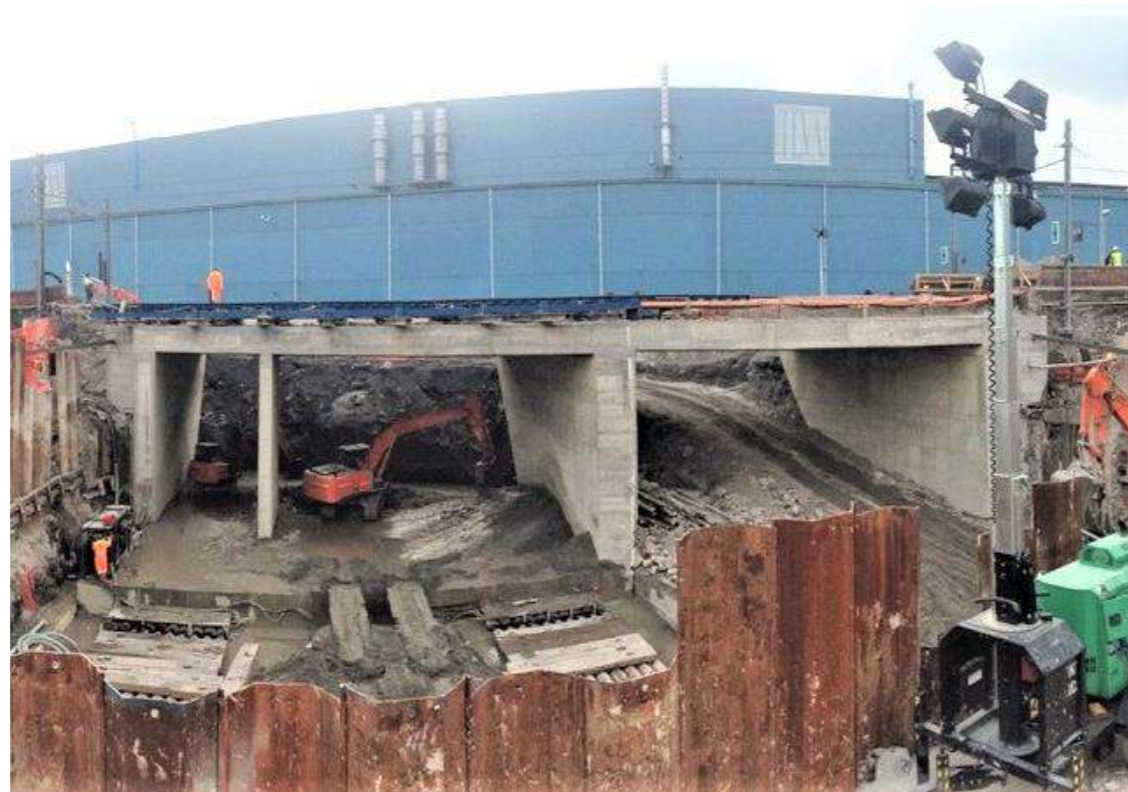
Figura 8 - Fasi finali della spinta
